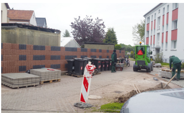
Bauarbeiten Straße des Friedens in Hörselgau
